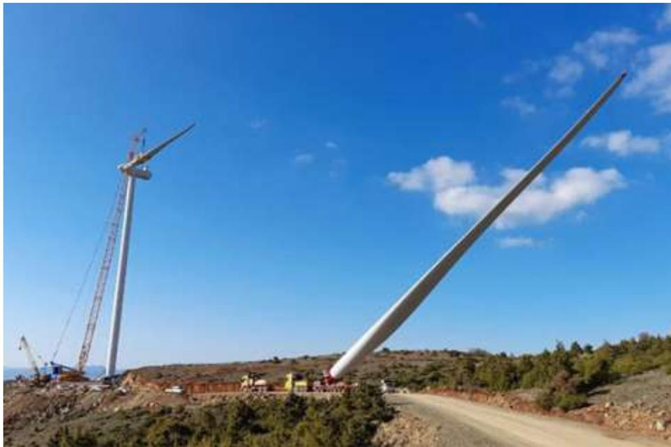
Esempio di trasporto di pala con blade lifter e di gru cingolata che deve essere smontata e rimontata ogni volta che si sposta da una piazzola all'altra
